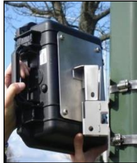
Figure 7. Pose finale du radar sur son support
